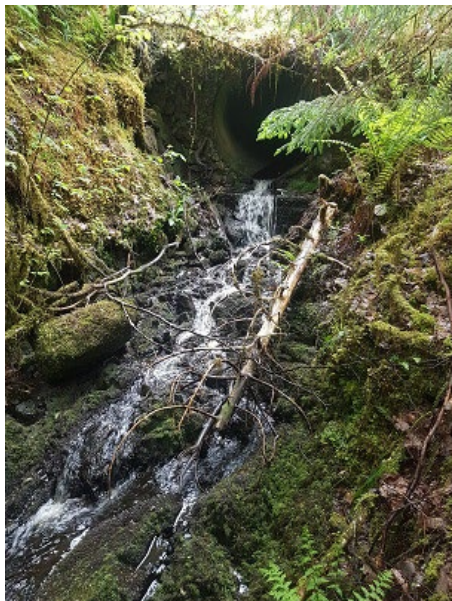
Fig. 3.1.3.1 Cascade/culvert obstacle ELM-01
